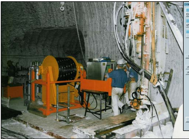
Abb.: Permeabilitäts-Messeinrichtung im Einsatz
