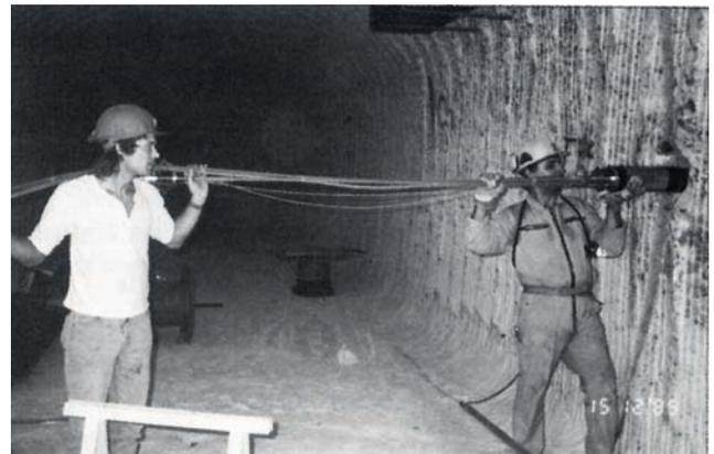
Die Voreinstellung der Wegaufnehmer erfolgt durch Spreizanker, mit denen auch der Verbund Ankergebirge gewährleistet wird. Diese Arbeiten werden mittels Setzgestänge vom Bohrlochmund aus in beliebige Einbaurichtungen ausgeführt.
