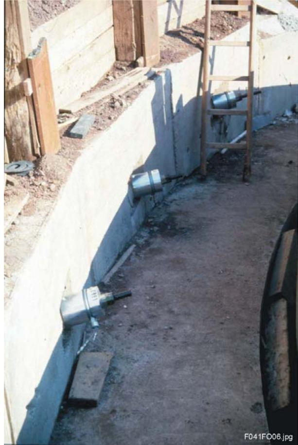
Abb.: Ankerkraftgeber in Einbauzustand
